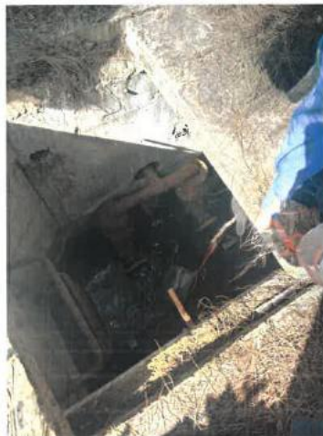
污水处理设施进口
