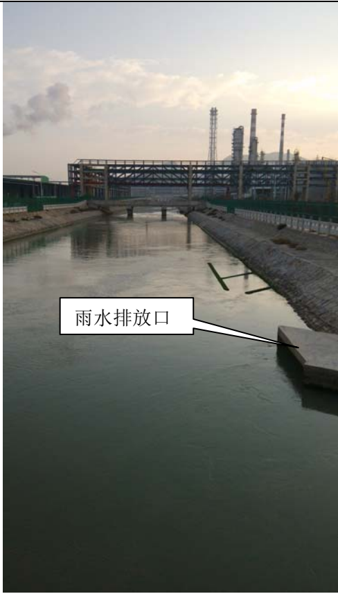
21 厂区雨水排放口
