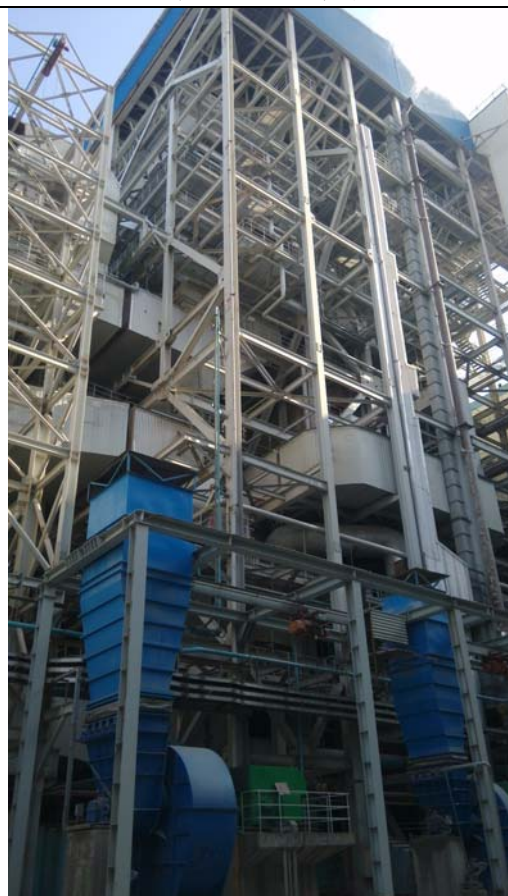
4 动力车间烟气处理—SCR 脱硝
