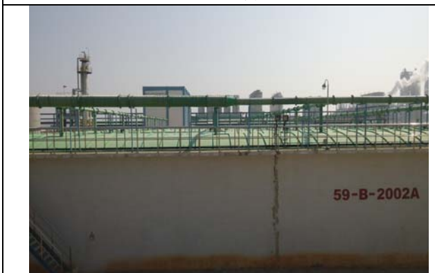
9 含油污水处理系统—AO 池
